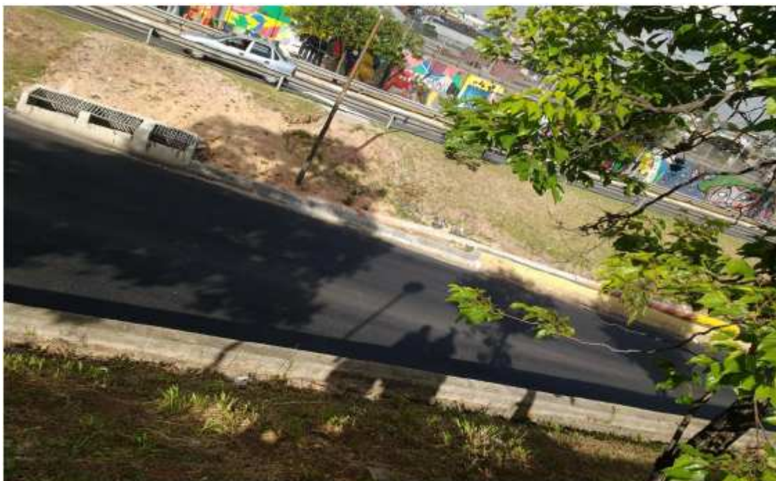
Radial Leste, início do túnel que sai na Aguia de Haia, presença de tubulação.
